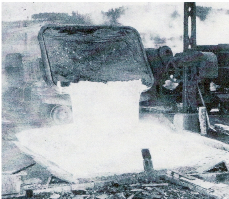
Füllen der Grube mit glufüssiger Rohüttenschlacke
