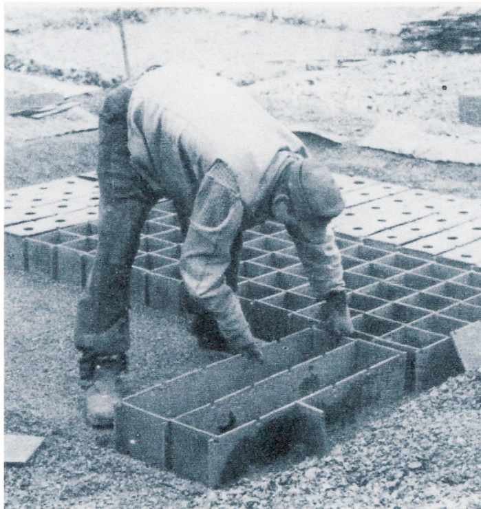
Facher beim Setzen der Bleche für Pflastersteine
